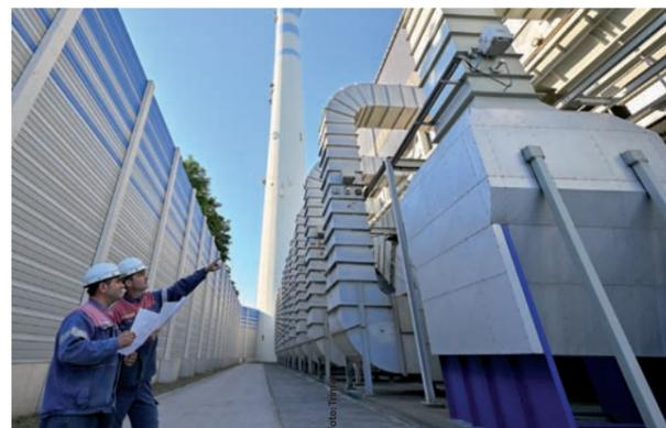
Die Abwärme der Aluminiumhütte in Essen kommt künftig der Fernwärmeversorgung von Iqony zugute
